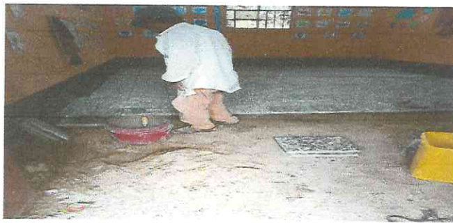
Foto 3: sustitucion de piso
