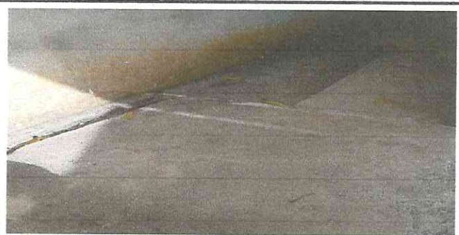
Foto 6: sustitucion de losa de patio
