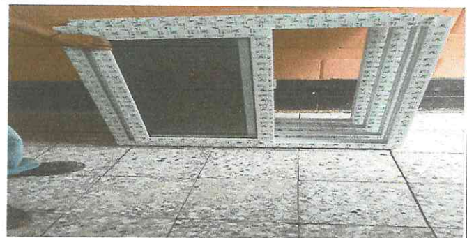
Foto 4: sustitucion de ventanas
