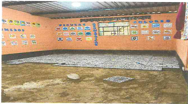
Foto 1: sustitucion de piso
