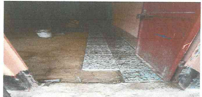
Foto 2: sustitucion de piso
