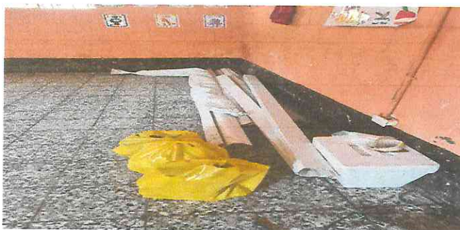
Foto 5: colocacion de canales de agua
